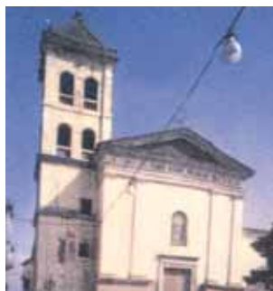
Fachada da Igreja de S. Mauro.
