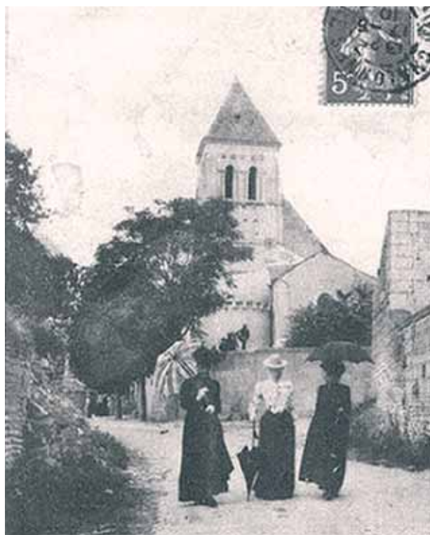
Église paroissiale des Hulmes
